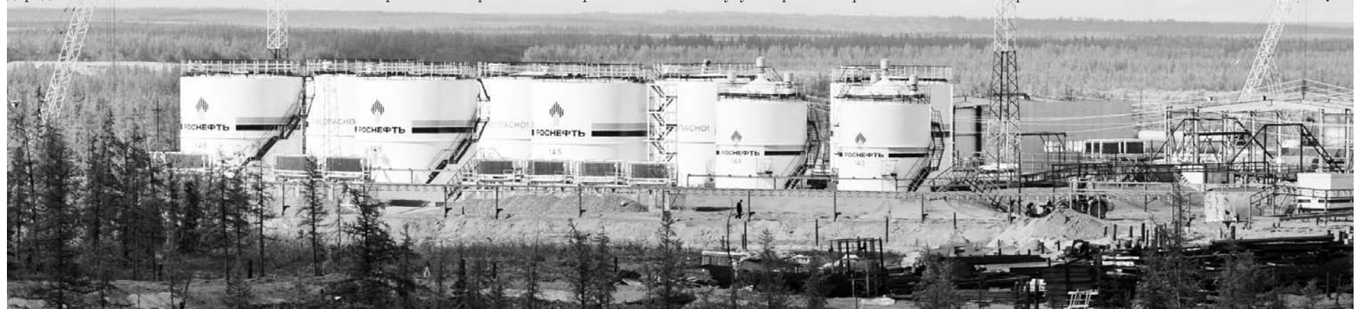
Ванкорское месторождение. Лето 2008 г. Обустройство месторождения.
